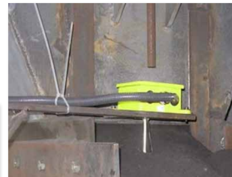
Montaggio sonda di temperatura
