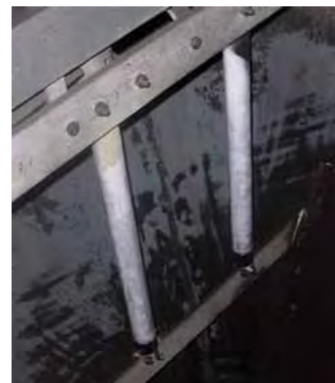
Montaggio dei sensori di umidità
