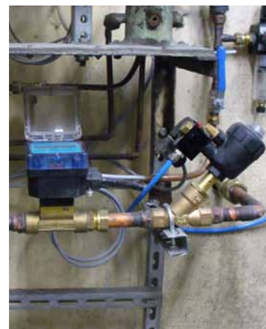
Монтаж дозирования воды
