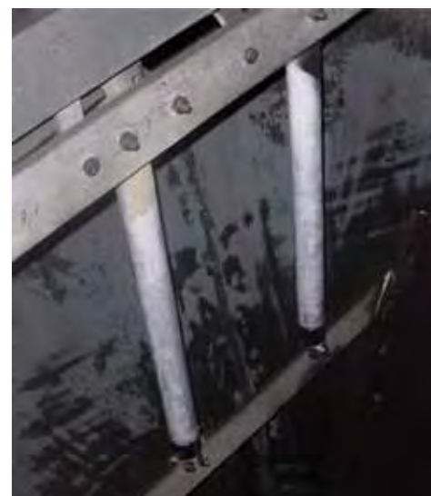
Установка датчиков влажности
