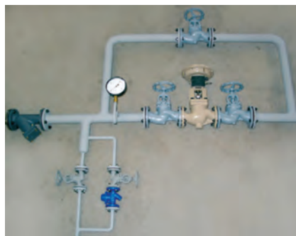
Unité de dosage de vapeur avec une valve électro-pneumatique DV- assemblage fini
