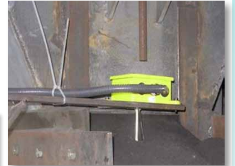
Sıcaklık sensörlerinin kurulumu
